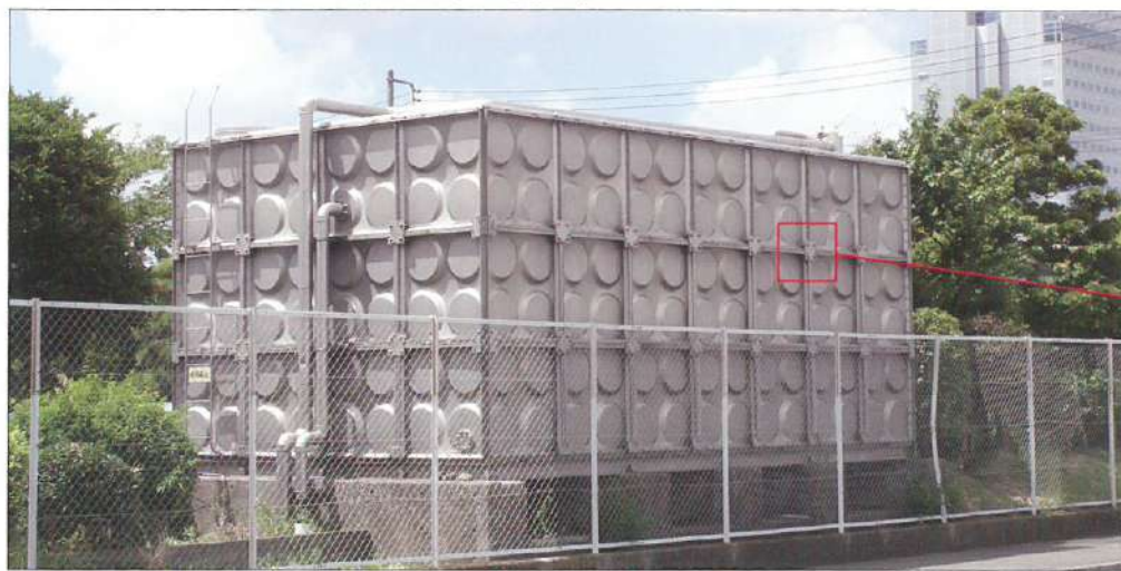
■ 施工後10年経過写真(2000年5月 施工)
