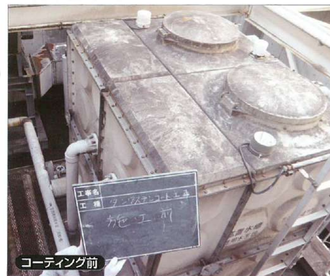
■ 高架水槽・天場
