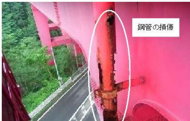
凍結防止剤による鋼管の腐食
