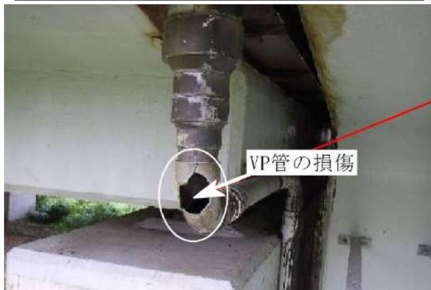
圧力変化等による隅角部の損傷
